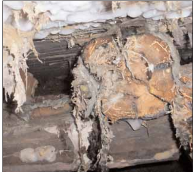
For utvendig treverk er det viktig å kontrollere alle steder med høy oppfuktning og dårlig optørking. Her et bilde fra et krypprom.
